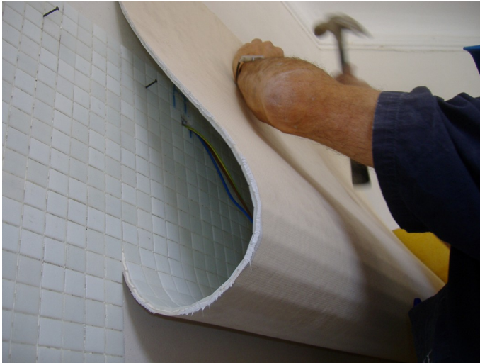
De flexibele opbouw van het mozaïekbehang van PRONTO MOZAĬEK, ontwikkeld voor een eenvoudige en snelle plaatsing.
