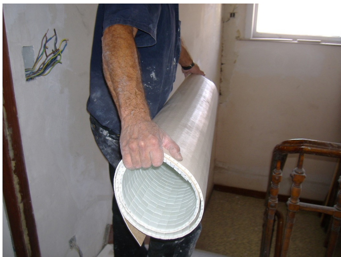
Een kant-en-klaar modulair mozaïekpaneel van PRONTO MOZAÏEK, gevoegd volgens kleurwens en bevestigd met tweecomponentenlijm.
