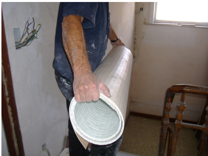
Un pannello modulare di mosaico PRONTO MOSAICO, pronto per la posa.
