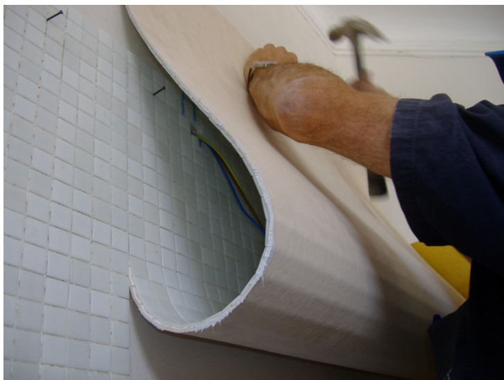
La struttura flessibile del rivestimento a mosaico PRONTO MOSAICO.
